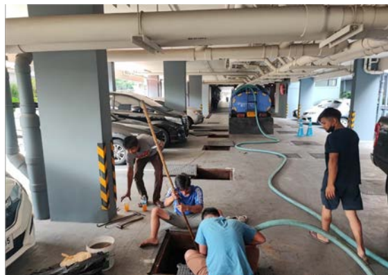
รูปที่ 2-12 การสูบล้างไขมัน
