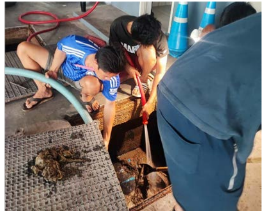
รูปที่ 2-11 การสูบล้างตะกอน
