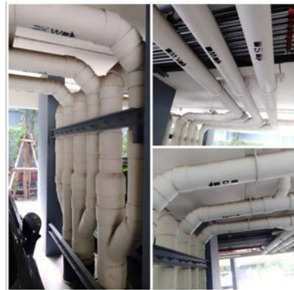
รูปที่ 2-34 ท่อรวบรวมน้ำเสียของห้องพักมูลฝอยรวม
